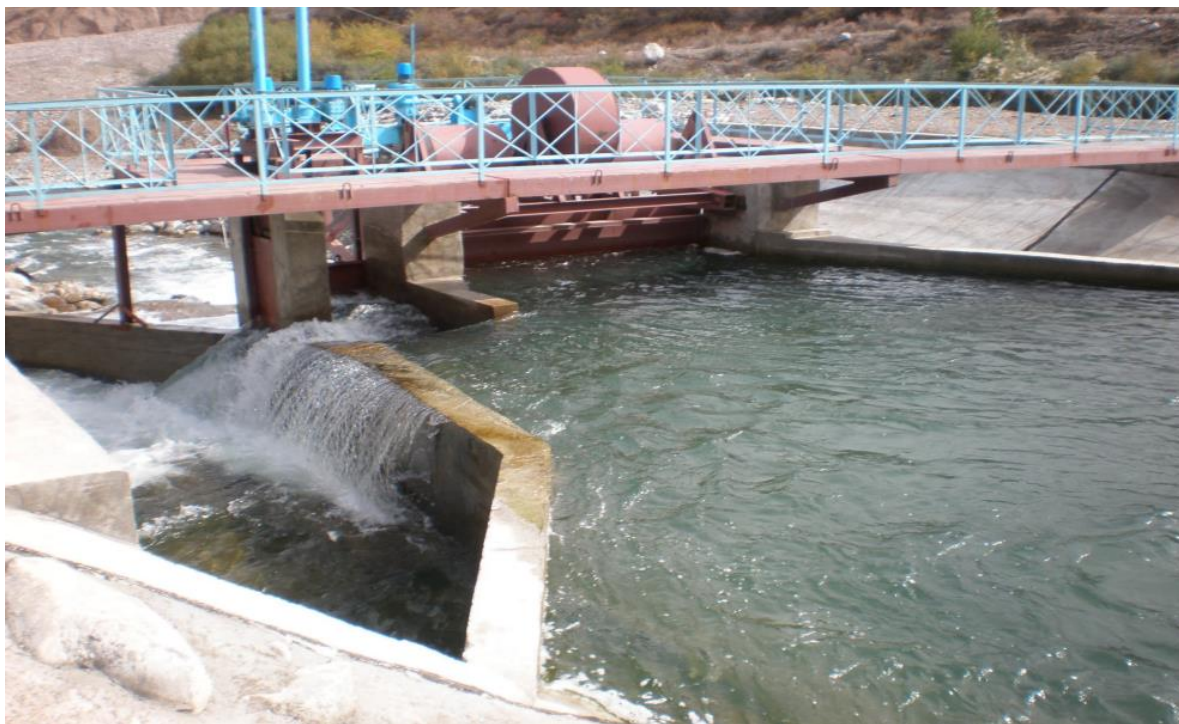
Рис. 1. Водозаборное сооружение на р. Иссык-Ата
